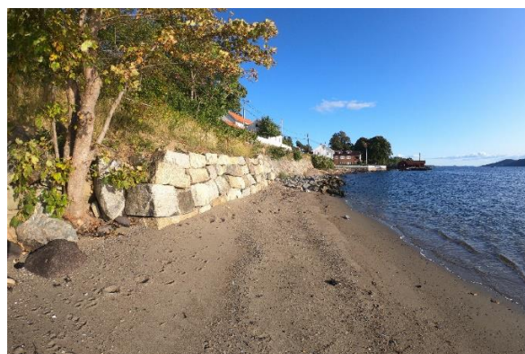
Fra forsterkningsmur mot bølgebryter
