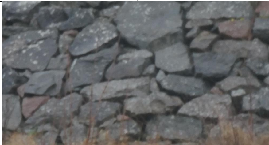
Eksempel: Plastring av front molomur
