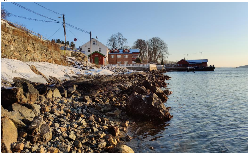
Bilde 1: Steinfylling/bølgebryter mellom sandstrand og toalett sett fra nord
