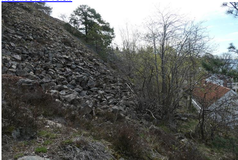
Kopås skråning mot husvikveien
