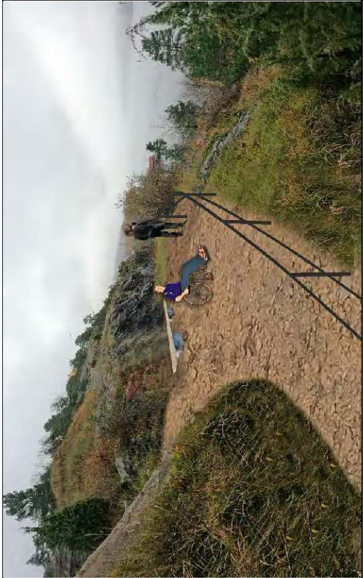
Kanonstilling mot syd med rekkverk, sti og sittebenk i eik og stein
