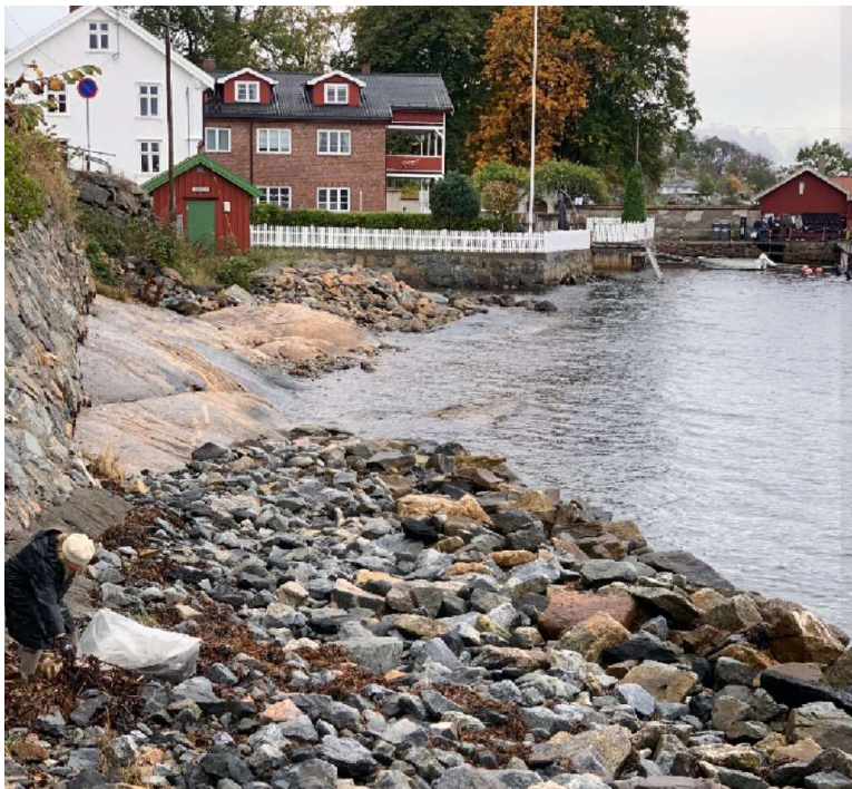
Strandpartiet der det er etablert en steinfylling med funksjon som bølgebryter. Dette for å hindre utrasing og utvasking av Husvikveien.
